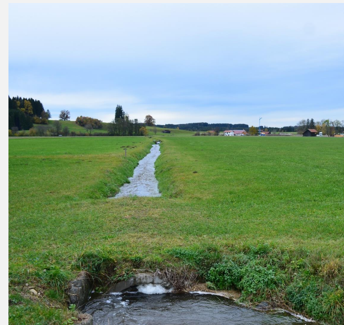
Versickerungsgraben „Beibach“ im HW-Fall: Das Untersuchungsgebiet verfügt über ein Hochwasserschutzsystem, das Hochwasser im Beibach um Ob herumleitet.
