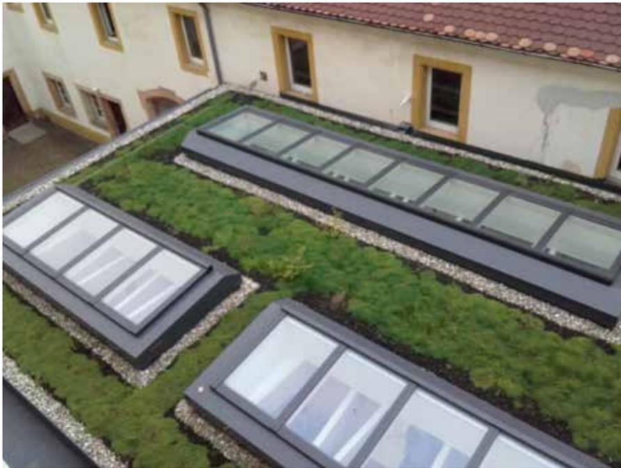
Möglich wurde das begrünte Flachdach mit großen Oberlichtern durch das selbsttragende und sich selbst aussteifende Dachtragwerk darunter. (Foto: Holzbau Wissing)
