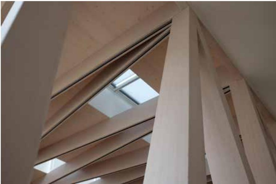
*Schmale Nuten in schmale Dachträger-Unterseiten zu fräsen, erfordert besonderes Werkzeug, Präzision und Vorsicht. Die später eingelegten LED-Lichtbänder unterstreichen die architektonische Wirkung der filigranen Konstruktion. (Foto: Hannsjörg Pohlmeier)*
