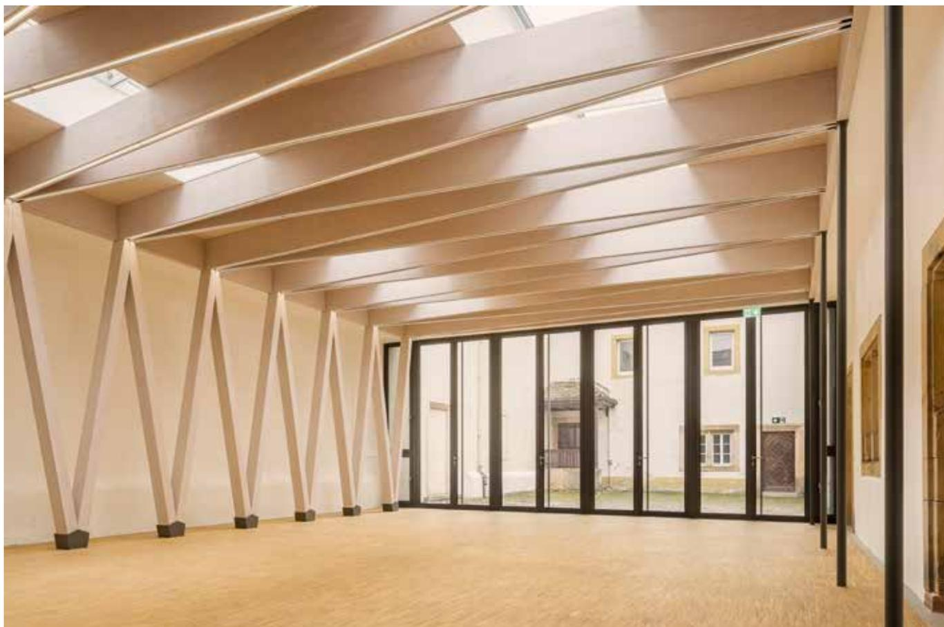
*Fotos 1 und 2: Ein Eingriff in die Bausubstanz des unter Denkmalschutz stehenden mittelalterlichen Schlosses von Bad Bergzabern war nicht erlaubt. Entstanden ist auf einer Fläche von 8,60 m x 12,50 m eine selbsttragende Konstruktion, die auch den Innenraum gestaltet. Licht fällt sowohl über die großzügigen Oberlichter als auch über die breite Fensterfront des Eingangsbereichs ins Innere des Saals. (Fotos: Daniel Wieser / Hannsjörg Pohlmeier)*
