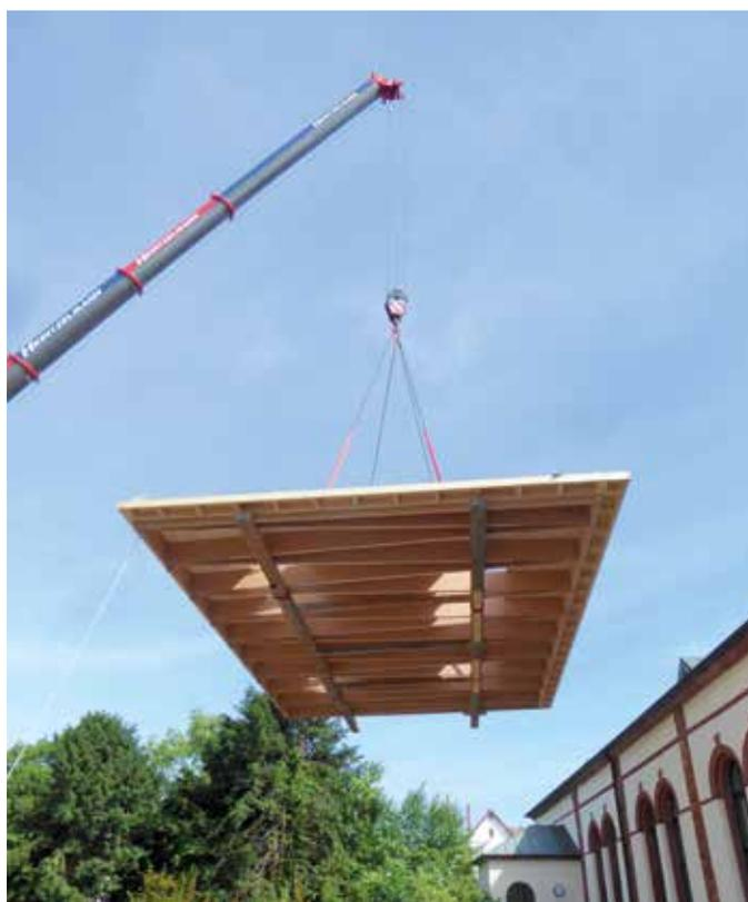
Einheben des Dachtragwerks über die Schlossmauern hinweg in den Innenhof per Kran. (Foto: Holzbau Wissing)
